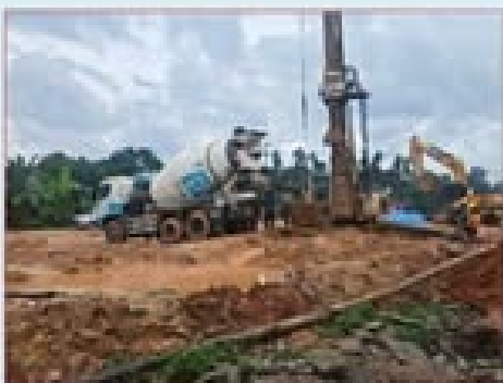
งานเสาเข็มเจาะหล่อในที่ งานสะพานข้ามทางรถไฟ
