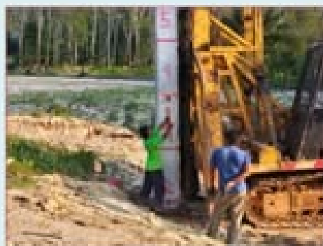
งานเสาเข็มคอกท่อสำเร็จ งานสะพานข้ามคลอง
