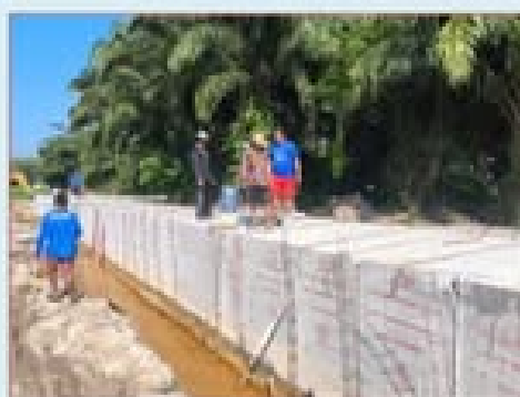
งานวาง ท่อระบายน้ำขนาด 1.80x1.80 m
